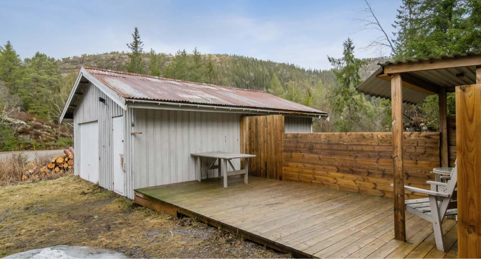
Opparbeidet uteområdet tilknyttet garasjen
