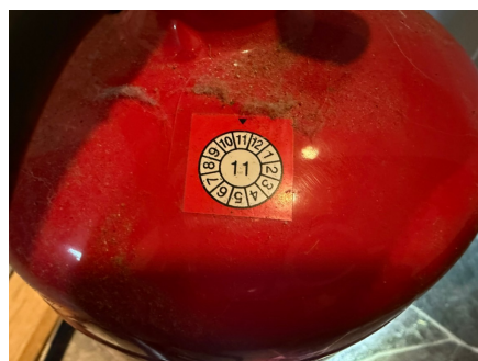
Brannslukningsapparatet er eldre en angitt brukstid.
