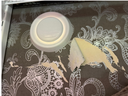
Eksempel på skadet tapet.
