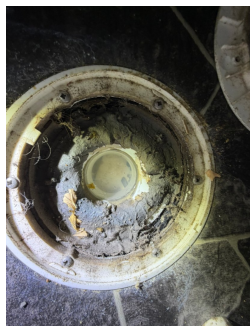
Plastsluk plassert under innredning.
