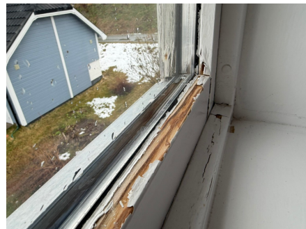
Eksempel på tegn etter kondensering.
