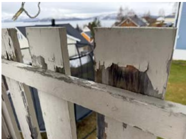
Eksempel på værslitte overflater.
