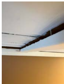
Takluken er forankret i taket med spiker.
