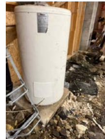
Berederen er plassert i et fuktig miljø.
