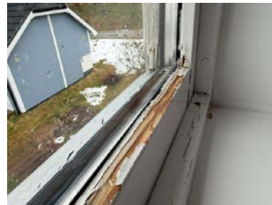
Eksempel på tegn etter kondensering.
