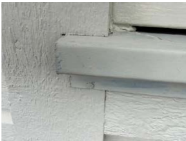
Eksempel på omramming som støter mot beslaget.
