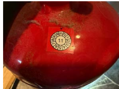
Brannslukningsapparatet er eldre en angitt brukstid.
