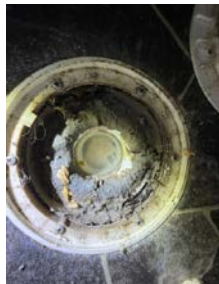
Plastsluk plassert under innredning.
