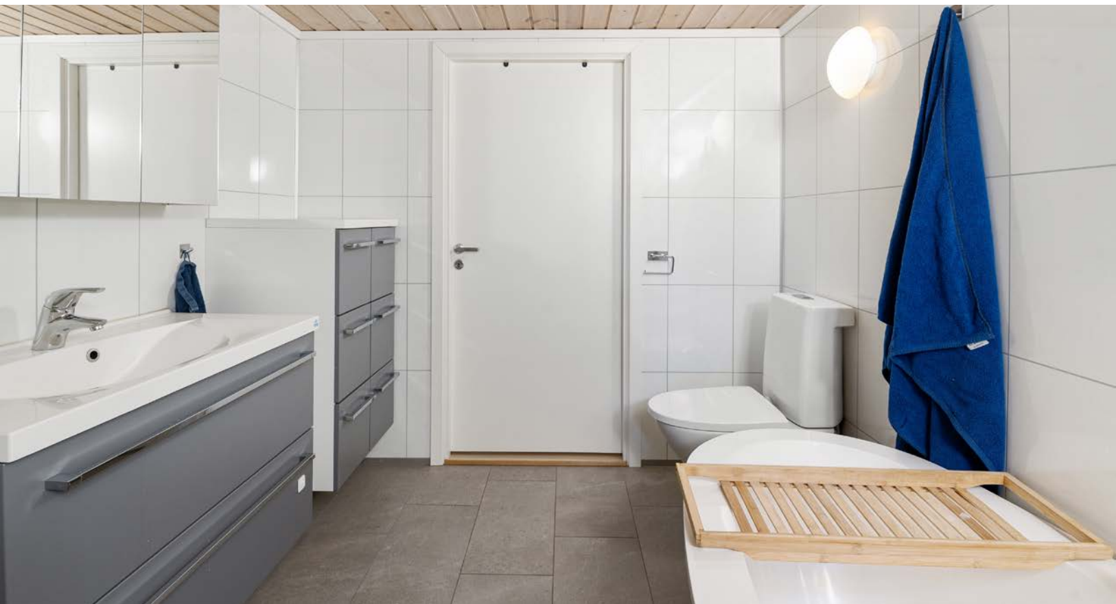
Fliser på gulv og våtromsplater på vegg. Varmekabler i gulv. (ikke byggesjekk)
