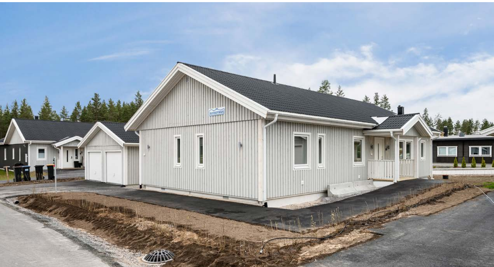
Tomten er opparbeidet med asfaltert innkjørsel.
