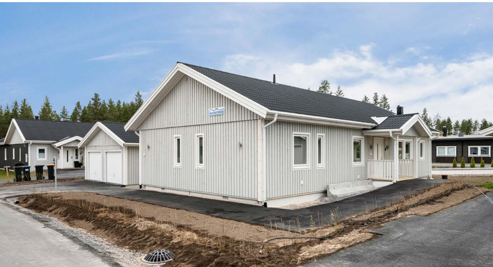
Tomten er opparbeidet med asfaltert innkjørsel.
