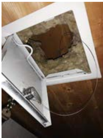
Felle montert i tak.
