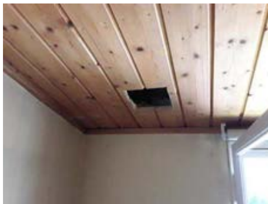
Inspeksjonsluker laget hos forsikringstaker.
