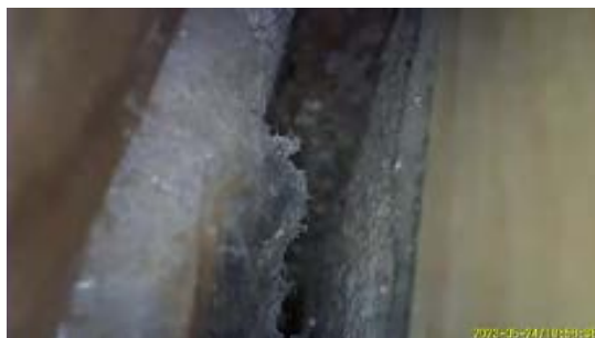
Bilde viser mellomrom i sålen mellom enhetene.
