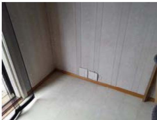
Åpnet vegg på kjøkken
