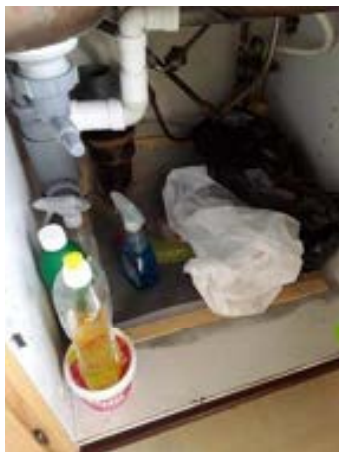
Eier har montert netting i kjøkkenbenk.
