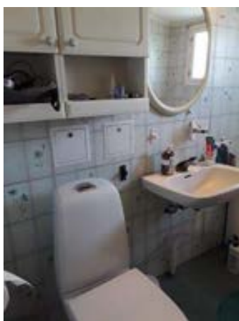
Eier har montert inspeksjonsluker over toalett.
