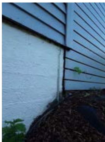
Det er utført gnagersikring i hjørnekasse.
