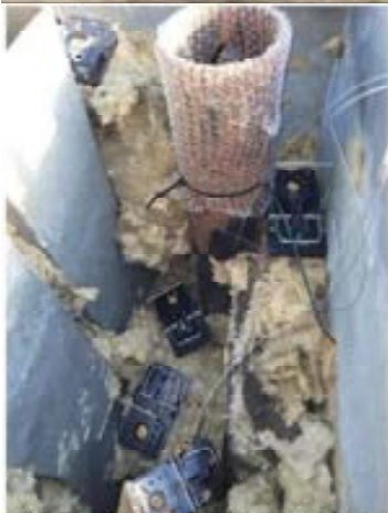
Sikret soilrør for lufting av kloakk over tak og satt ut feller på taket ved rør.
