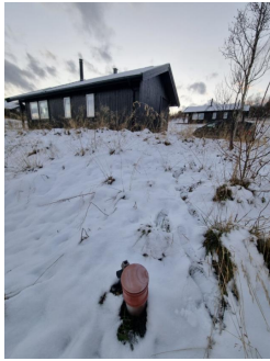
Utvendig stoppekrane og stakepunkt for avløp nedenfor hytten
