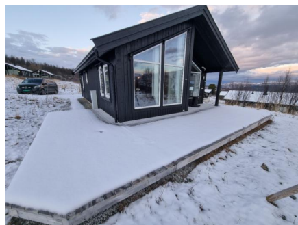
Terrasse med utgang fra stue
