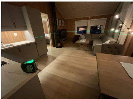
1. etasje Plassering av laser ved kontroll av stue/kjøkken. Det er målt 9 mm høydeforskjell gjennom rommet. TG 1
