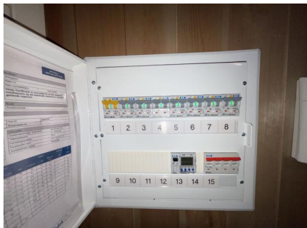
Innvendig sikringsskap
