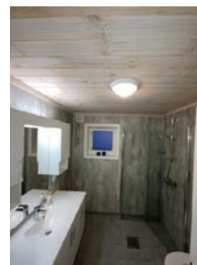
Vindu er plassert i våtsone utenfor dusjvegger
