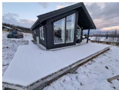
Terrasse med utgang fra stue
