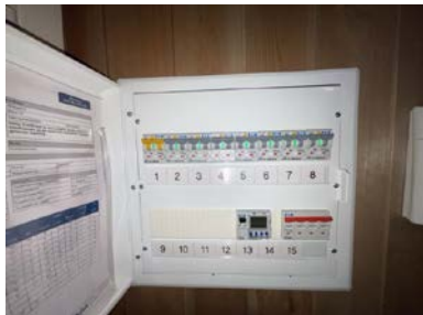
Innvendig sikringsskap
