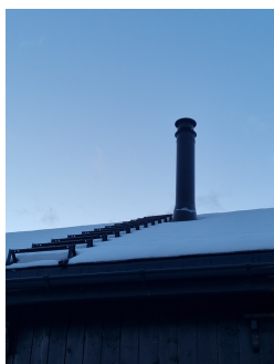
Bilde hentet fra befaring utført 29.10.2024
