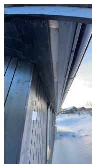
Synlig luftespalte i raftekaske ved overgang tak/vegg
