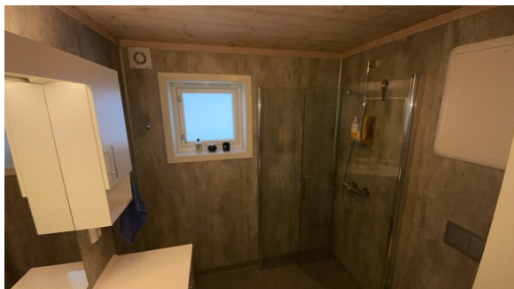
Vindu er plassert i våtsone utenfor dusjvegger
