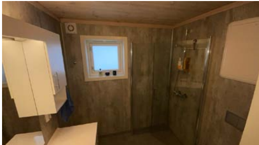
Vindu er plassert i våtsone utenfor dusjvegger
