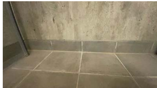
Mangler tilstrekkelig med mykfuge ved overgang veggflis mot sokkellist våtromspanel i våtsone dusj.
