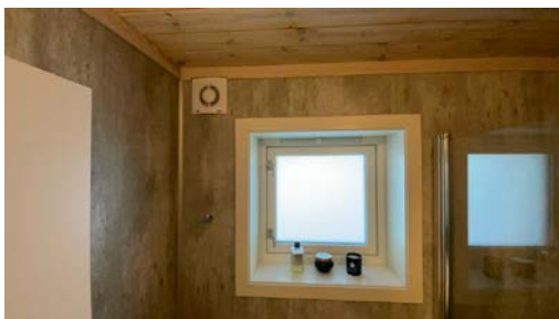
Mekanisk avtrekk på vegg og åpningsvindu med ventil
