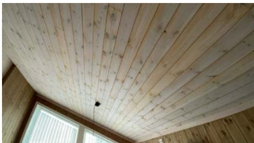
Overflatebehandling på panel i himling er ujevn.
