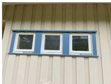
Koblede vinduer i trapperom.
