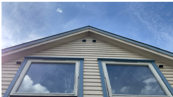
Ventilering av takkonstruksjon er synlig oppe på gavelvegg
