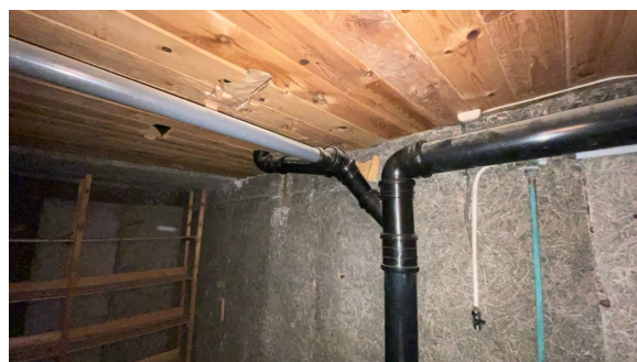
Åpne rør inne i kjellerboden
