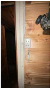
Lampettledning er tilkoblet inn under stikkontakt i kjeller
