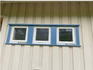
Koblede vinduer i trapperom.
