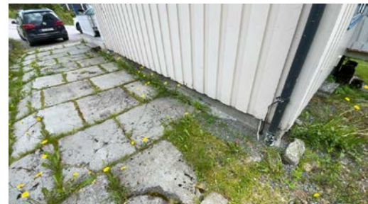
På oversiden er det synlig støpt på grunnmur
