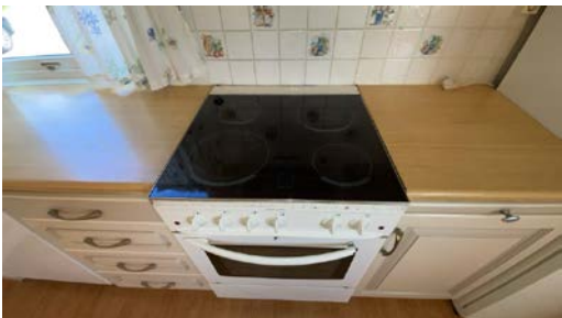
Slitasje på lakk ved keramisk topp på komfyr. Skade på kantlist benkeplate
