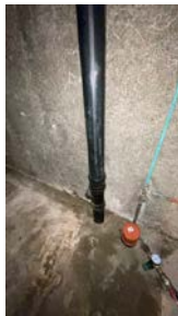
Stakeluke er tilgjengelig inne på kjellerbod
