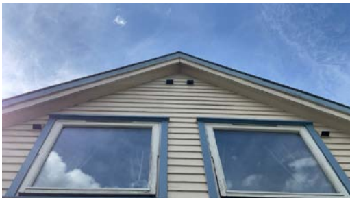
Ventilering av takkonstruksjon er synlig oppe på gavelvegg
