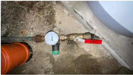
Hovedstoppekrane med reduksjonsventil
