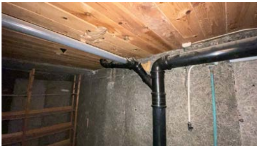
Åpne rør inne i kjellerboden
