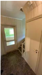
Dører til stue og trapperom sett fra gang i 1. etasje
