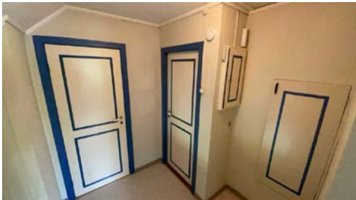
Dører til soverom 3, soverom 2 og kott sett fra gang i 2. etasje
