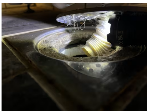
Membran er ikke synlig ført under klemring i sluk.
