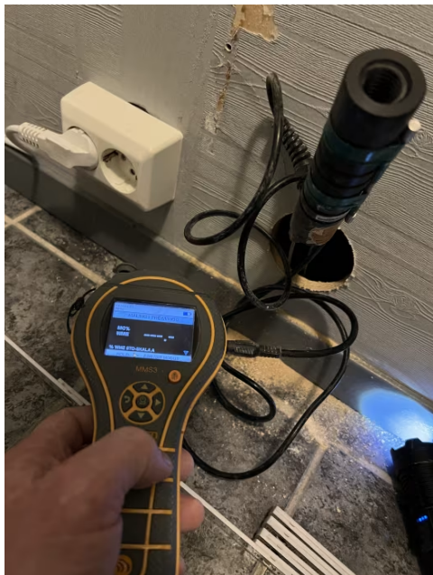
Det ble ikke registrert fukt i veg ved hulltaking fra tilstøtende rom.
