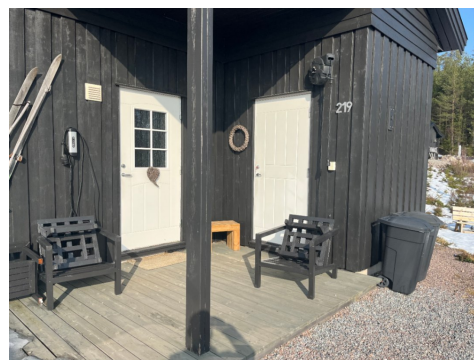
Tilliggende bod ved inngangsparti.
