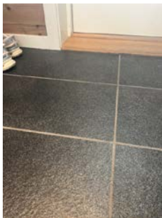
Tregulv med sprekker og skjøter ikke er forskjøvet.
