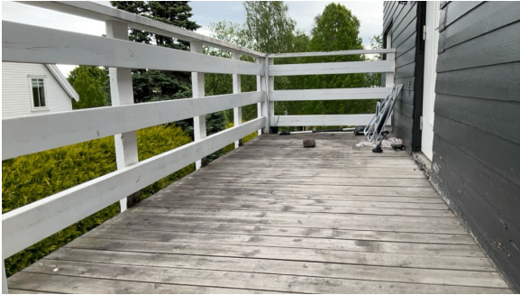
Åpninger i rekkverk er større enn dagens anbefaling.
