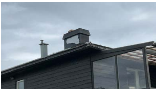
Flassing på takrenner/beslag.
