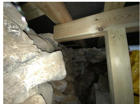
Besiktigelse av kryprom.
