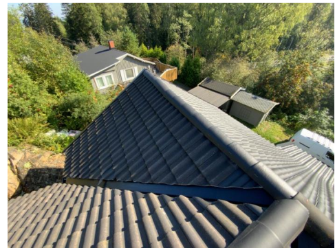
Besiktigelse av taktekke.
