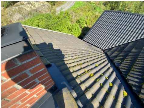
Besiktigelse av taktekke.
