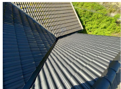
Besiktigelse av taktekke.
