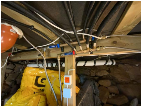
Besiktigelse av røropplegg.
