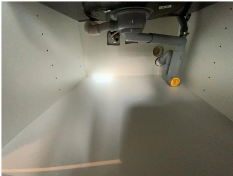
Besiktigelse av røropplegg.
