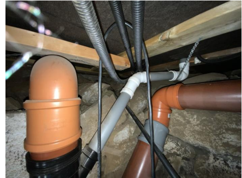
Besiktigelse av kryprom.
