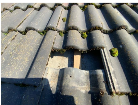
Kontroll av undertak.
