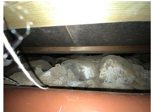
Besiktigelse av kryprom.
