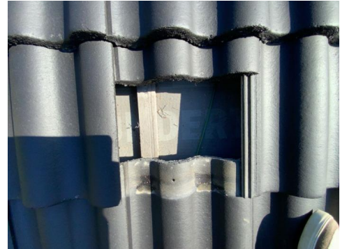
Kontroll av undertak.
