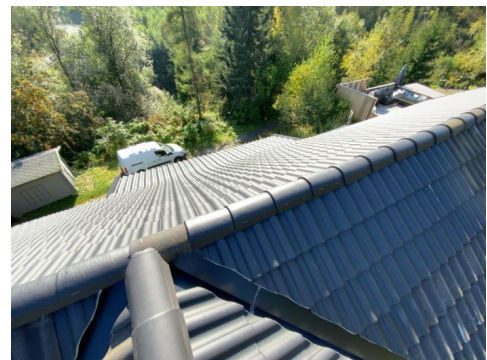
Besiktigelse av taktekke.
