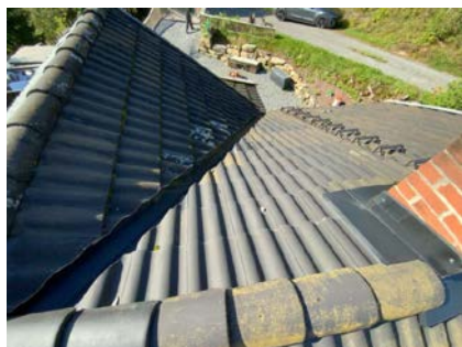
Besiktigelse av taktekke.
