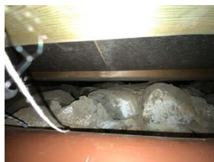
Besiktigelse av kryprom.
