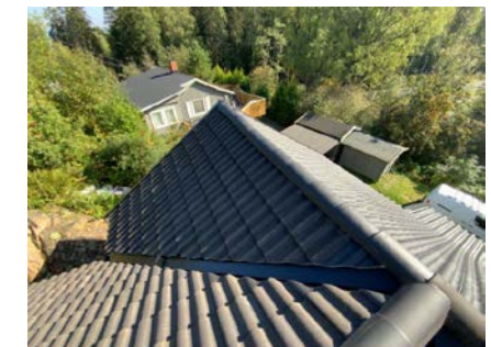
Besiktigelse av taktekke.
