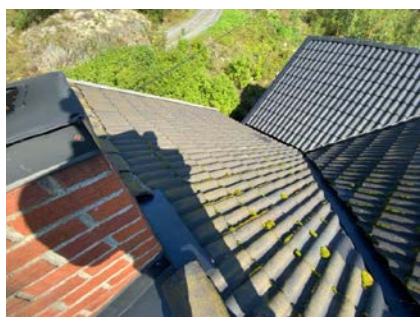
Besiktigelse av taktekke.
