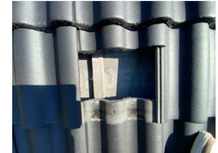
Kontroll av undertak.
