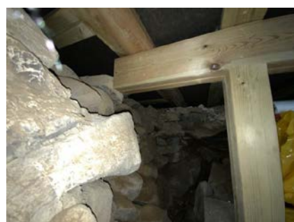
Besiktigelse av kryprom.
