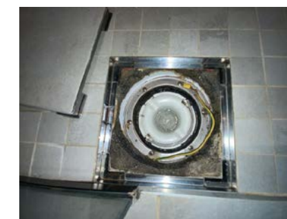
Kontroll av sluk.
