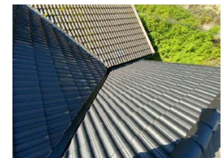
Besiktigelse av taktekke.
