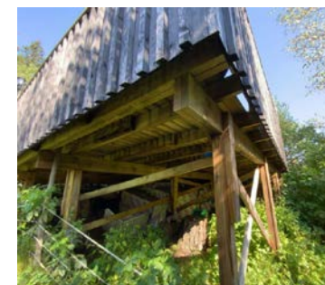
Kontroll av fundament.
