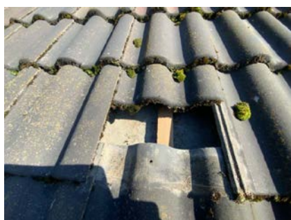
Kontroll av undertak.
