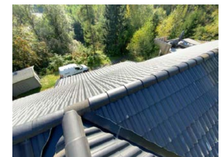
Besiktigelse av taktekke.
