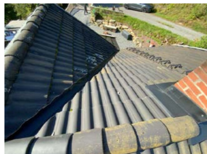
Besiktigelse av taktekke.
