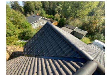
Besiktigelse av taktekke.
