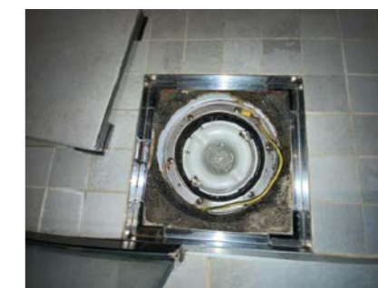
Kontroll av sluk.
