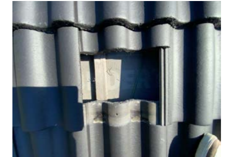
Kontroll av undertak.
