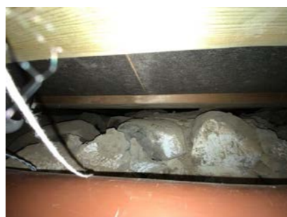
Besiktigelse av kryprom.
