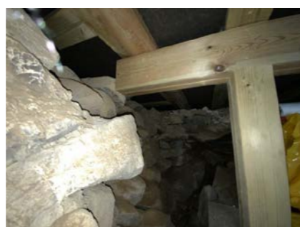
Besiktigelse av kryprom.
