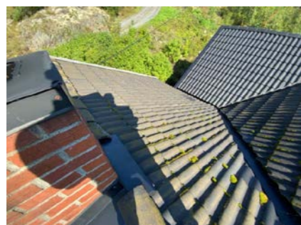
Besiktigelse av taktekke.
