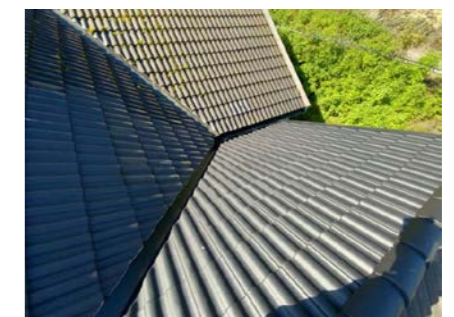
Besiktigelse av taktekke.
