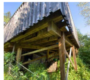
Kontroll av fundament.
