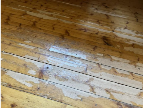
Slitasje på overflater
