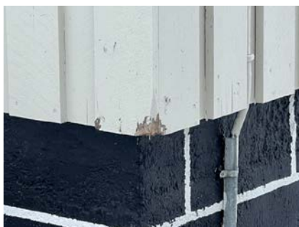
Sprekk i kledningsbord
