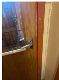
Tilstandsgrad satt utifra alder og slitasje
