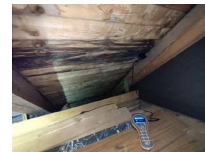
Misfarget undertak, lite luft i nedre del. Ikke målt unormalt med fukt.
