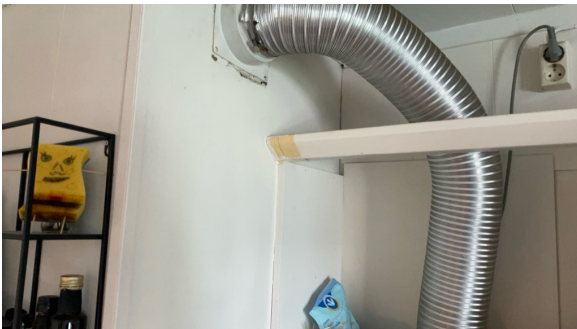
Pipevange er kledd inn i 1. etasje.
