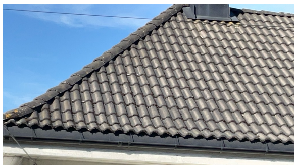
Tak sjekket fra bakkenivå
