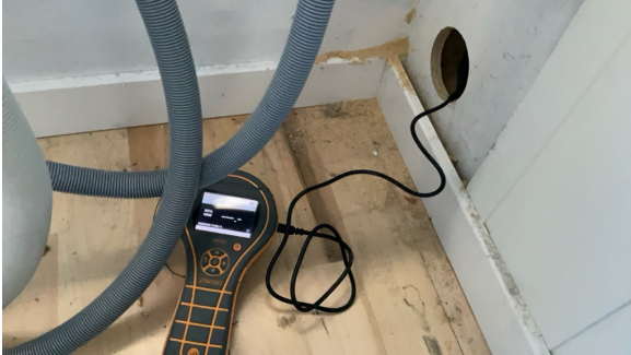
Fuktmåling i konstruksjon mot dusjsone.
