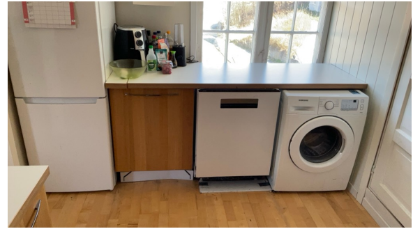
Opplegg til vaskemaskin og oppvaskmaskin
