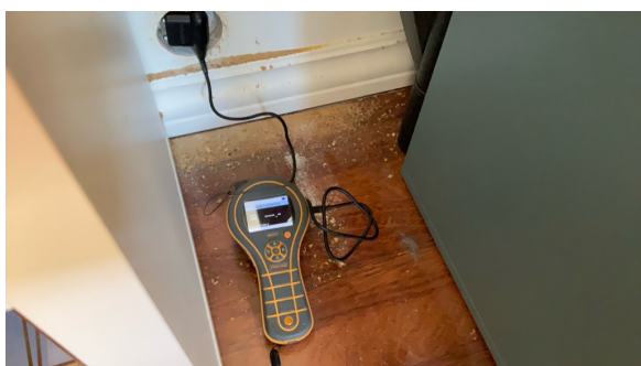
Fuktmåling i vegg mot bad.
