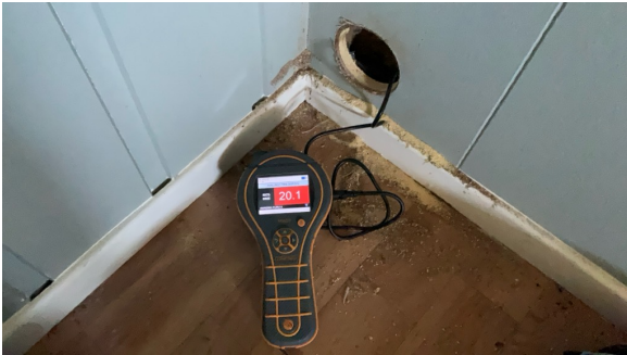
Fuktmåling i alkove i underetasjen.
