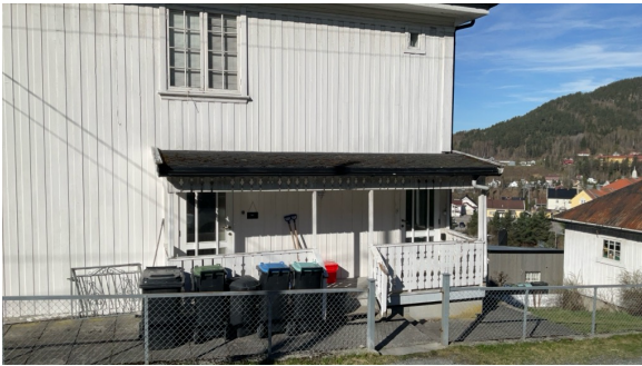
Tak over inngangsparti.
