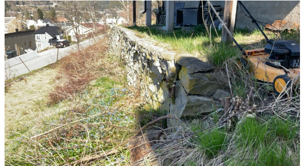
Støttemur i naturstein med skjevheter.
