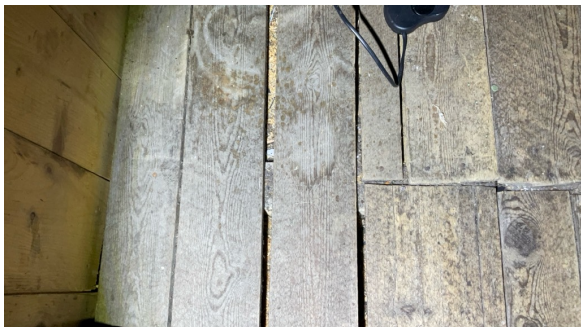
Etasjeskille isolert med flis.
