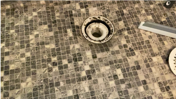
Plastsluk med belegg klemt med klemring.
