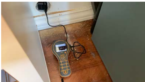
Fuktmåling i vegg mot bad.
