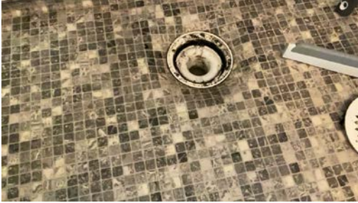
Plastsluk med belegg klemt med klemring.
