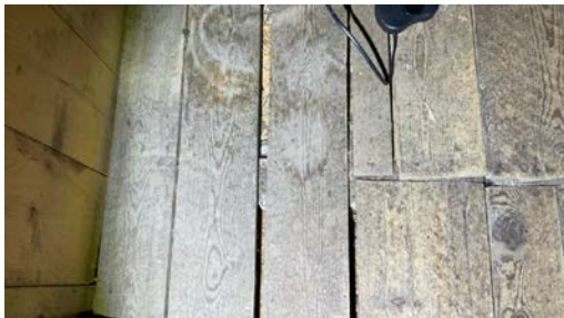
Etaseskille isolert med flis.
