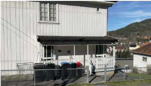
Tak over inngangsparti.
