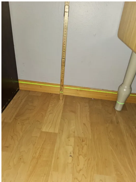
Bilde viser måling av etasjeskiller.
