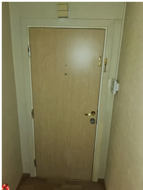
Bilde viser entrédør.
