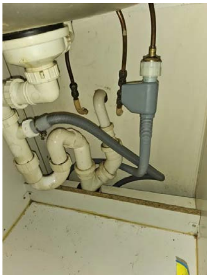
Bilde viser avløpsrør under oppvaskkum på kjøkken.
