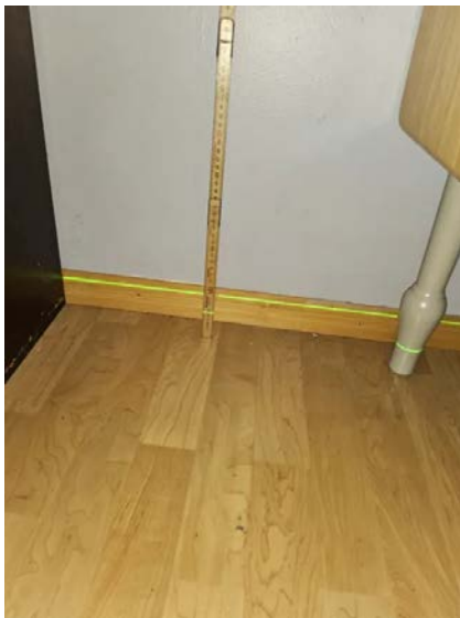
Bilde viser måling av etasjeskiller.
