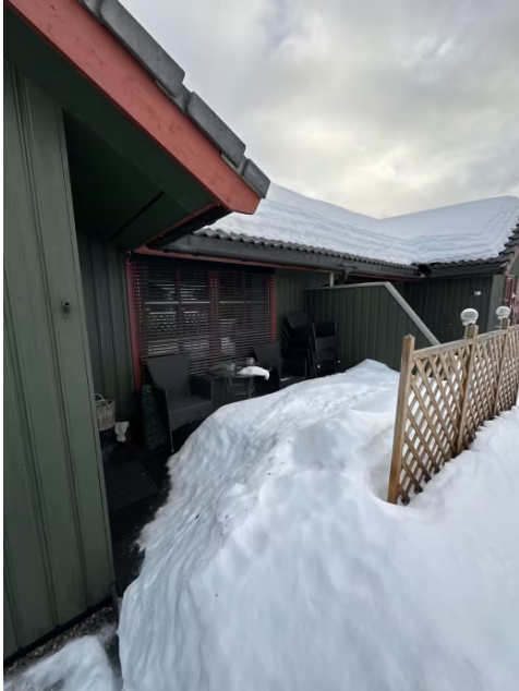
Viser terrasse mot sør. Det bør foretas nærmere undersøkelser av terrasser når den er snøfri.
