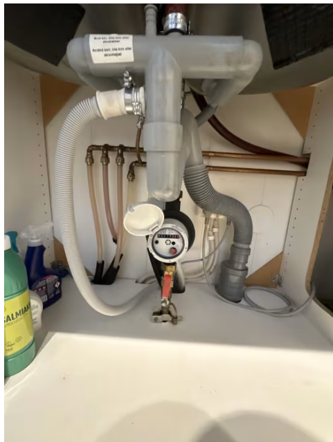
Viser vann og avløpsinstallasjoner under kum.
