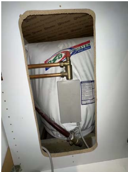
Viser bereder plassert i kjøkkenskap.
