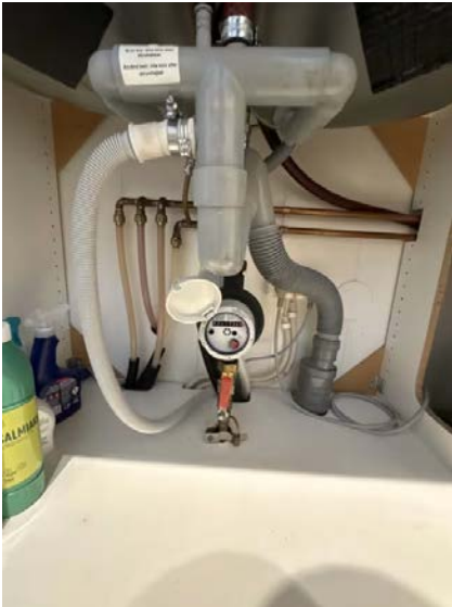
Viser vann og avløpsinstallasjoner under kum.
