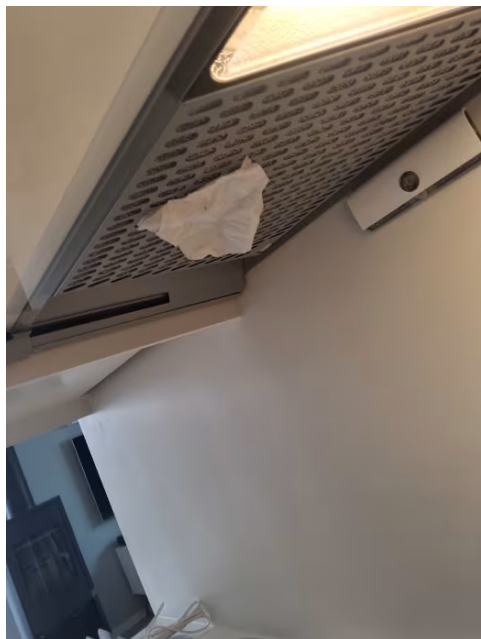
Avtrekkseffekten er kontrollert med papir.
