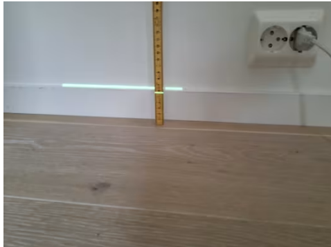
Etasjeskille ble kontrollert med nivelleringslaser.
