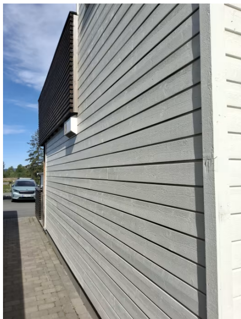
Boligen er kledd med liggende trekledning.
