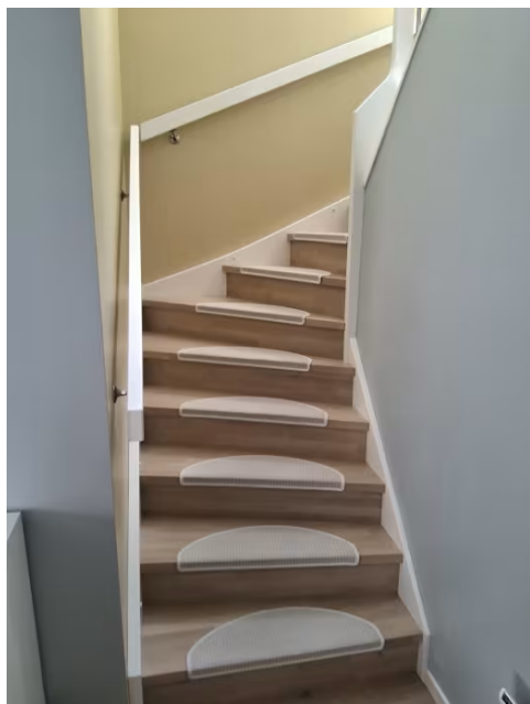
Lukket tretrapp mellom etasjene.
