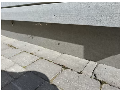
Grunnmur er kledd med utvendig platekledning.
