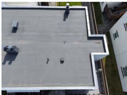
Boligen er oppført med flatt tak med parapet.
