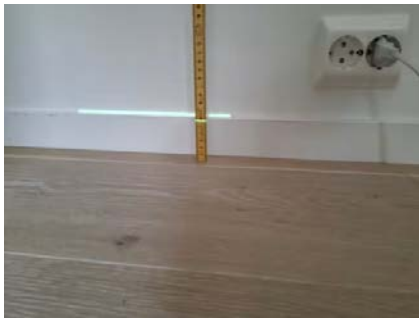
Etasjeskille ble kontrollert med nivelleringslaser.
