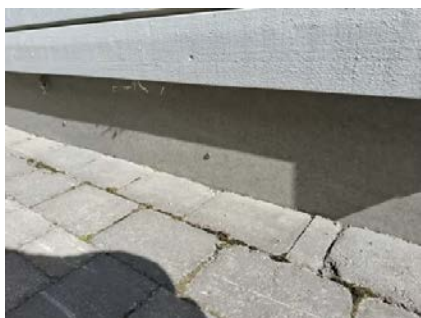
Grunnmur er kledd med utvendig plateledning.
