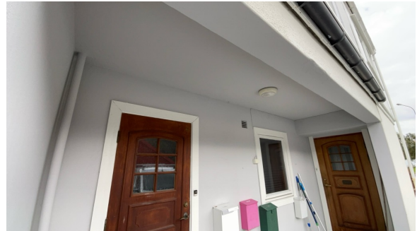
Synlig betongdekke ved inngang
