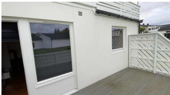
Vindu på stue
