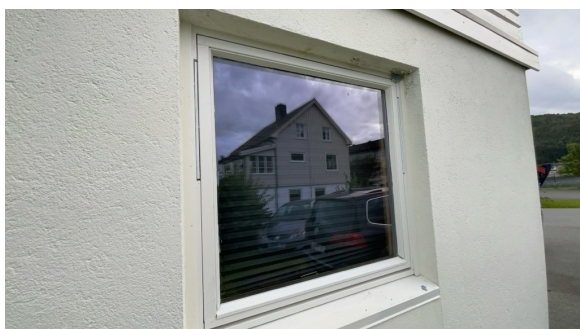
Vindu på soverom 1
