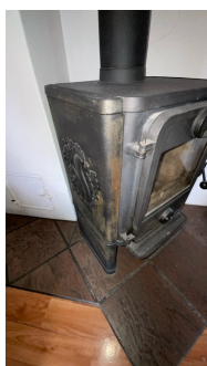
Synlig rust på overflate av vedovn
