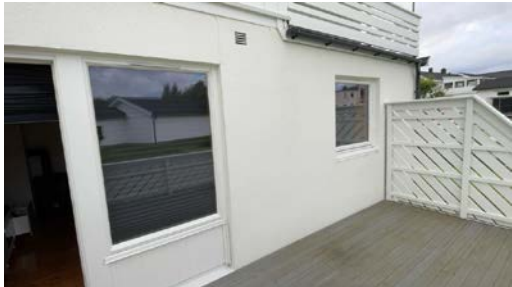
Vindu på stue
