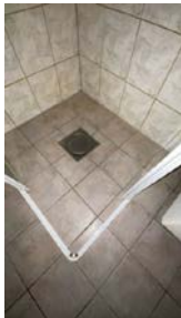
Gulvskinne for dusj avgrenser rommet mot sluk
