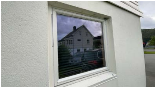
Vindu på soverom 1
