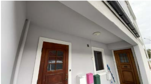
Synlig betongdekke ved inngang
