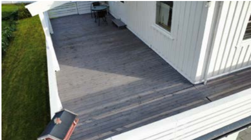
Oversikt veranda til leilighet B som fungerer som tak til leilighet A
