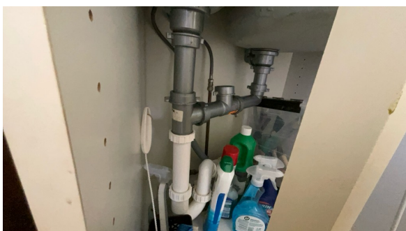
Del av rør til avløp.
