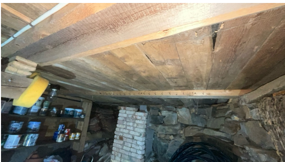
Del av etasjeskille sett fra krypkjeller.
