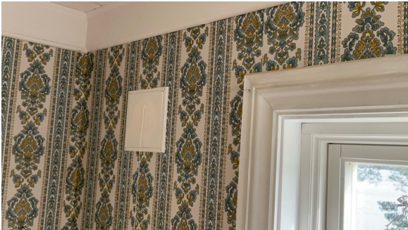
Eksempel på montert ventil i vegg.
