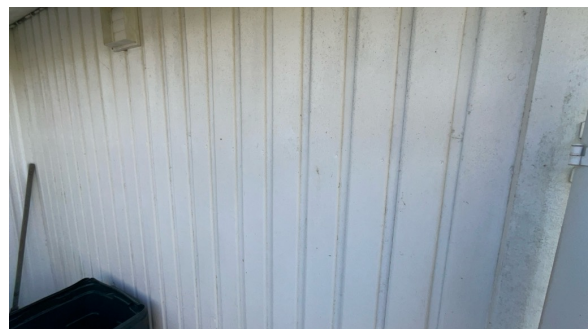
Del av vegg.
