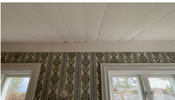
Del av vegg - tak.
