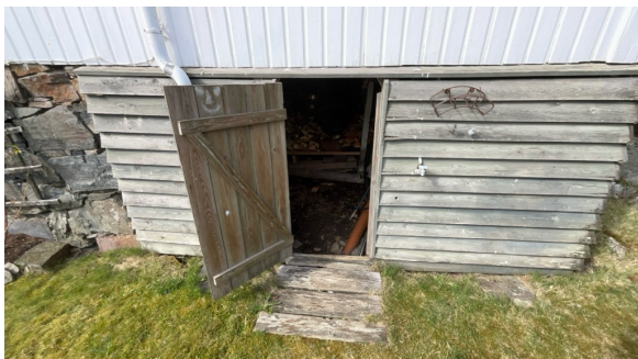
Luke inn til krypkjeller.
