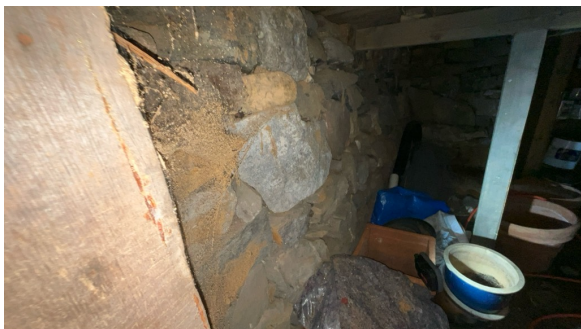
Del av grunnmur.
