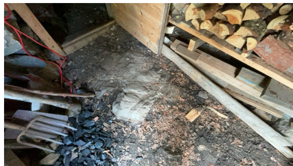
Del av krypkjeller.
