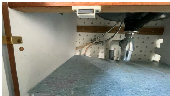
Del av rør til vann.
