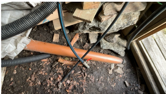
Del av rør til avløp.
