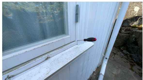
Stikk kontroll på vinduer er utført.
