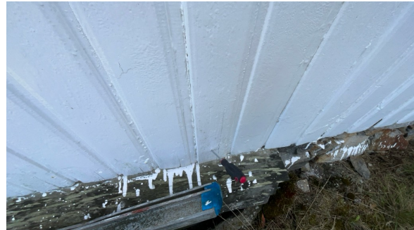
Stikk kontroll av vegger er utført.
