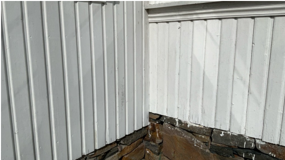
Del av vegg.
