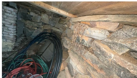
Del av grunnmur.
