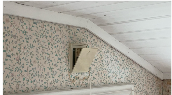
Eksempel på montert ventil i vegg.
