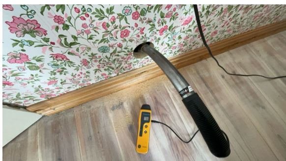
Hull for kontroll av fukt.
