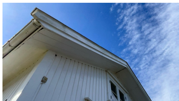
Del av gesims.
