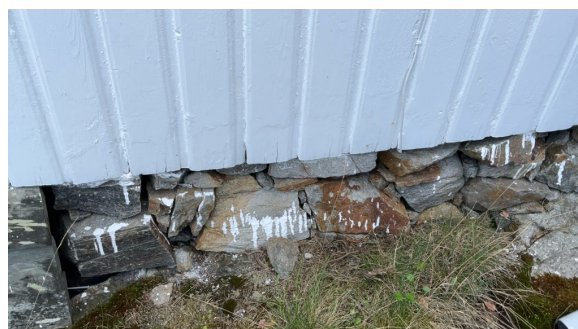
Del av grunnmur.
