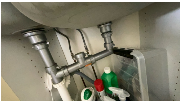
Del av rør til vann.
