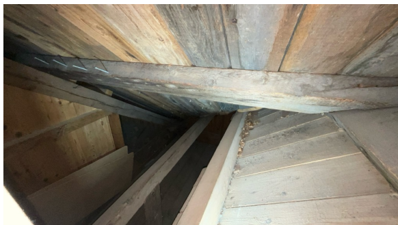
Del av takkonstruksjon, sett fra loft.
