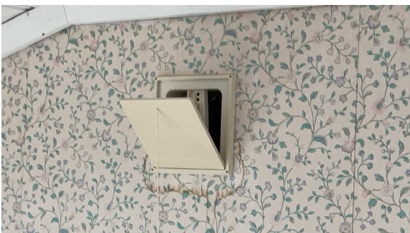
Eksempel på montert ventil i vegg.
