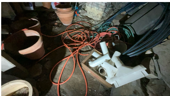
Del av krypkjeller.
