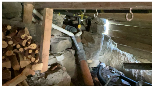
Del av rør til avløp.
