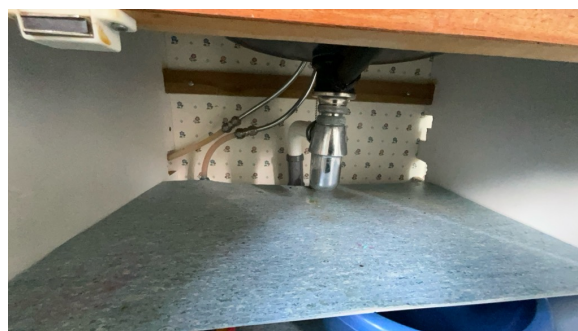
Del av rør til avløp.
