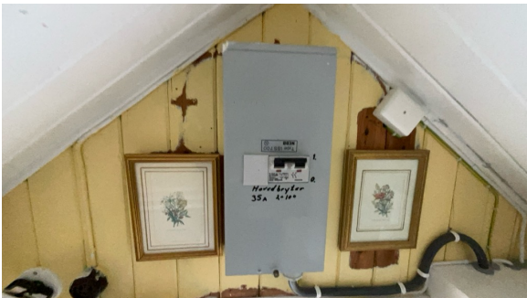
Inntak i 2 etasje.
