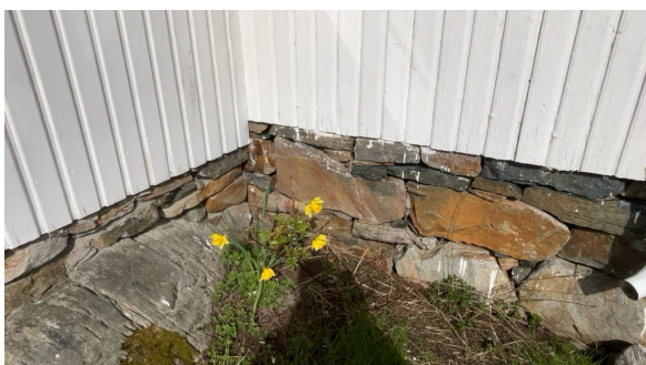
Del av grunnmur.
