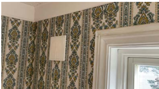
Eksempel på montert ventil i vegg.
