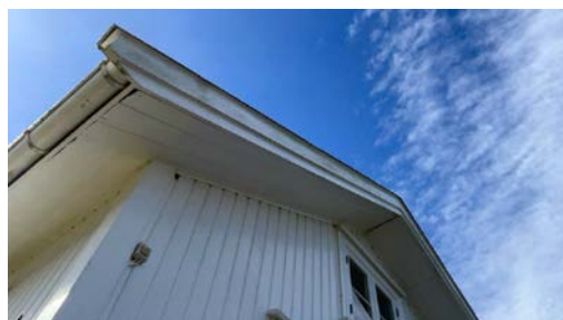
Del av gesims.
