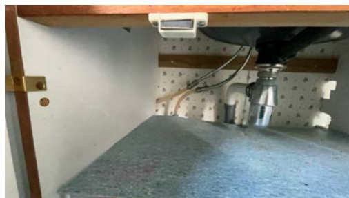
Del av rør til vann.
