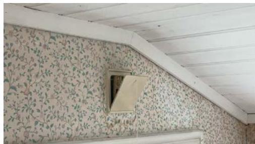
Eksempel på montert ventil i vegg.
