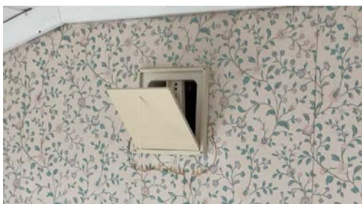
Eksempel på montert ventil i vegg.
