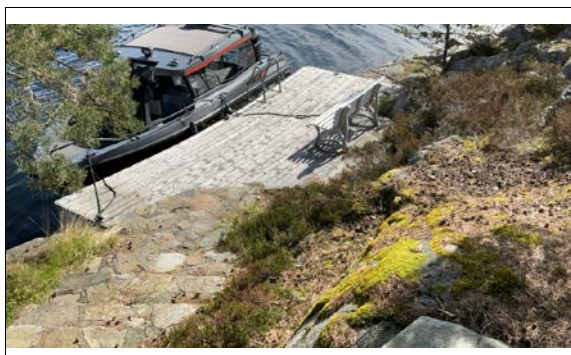
Brygge nord - øst på eiendommen
