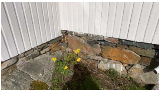
Del av grunnmur.
