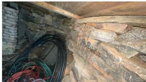
Del av grunnmur.
