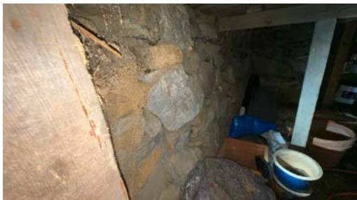
Del av grunnmur.
