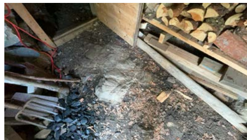
Del av krypkjeller.
