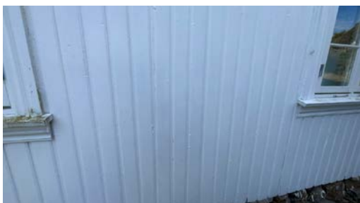
Del av vegg.
