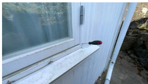
Stikkontroll på vinduer er utført.
