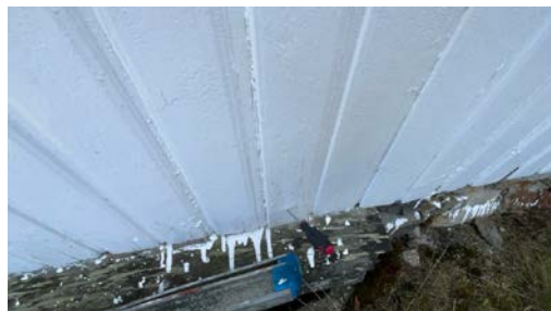
Stikk kontroll av vegger er utført.
