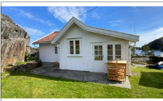
Hytte oppført på eiendommen.
