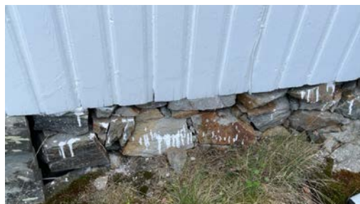
Del av grunnmur.
