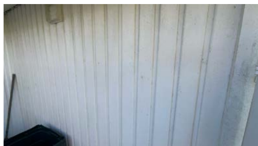
Del av vegg.
