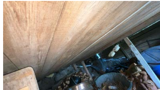
Del av etasjeskille sett fra krypkjeller.
