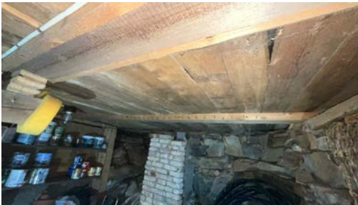
Del av etasjeskille sett fra krypkjeller.
