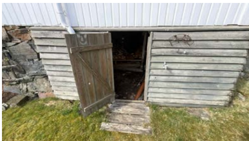
Luke inn til krypkjeller.
