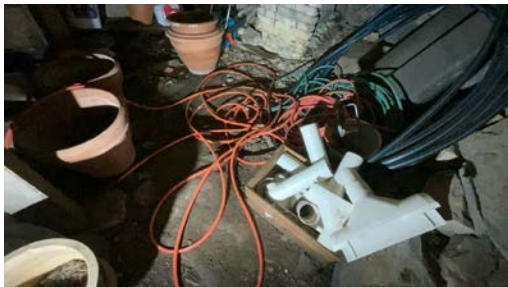
Del av krypkjeller.
