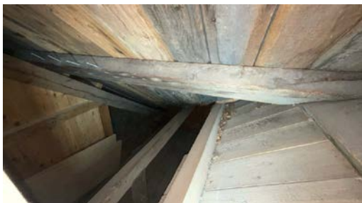
Del av takkonstruksjon, sett fra loft.
