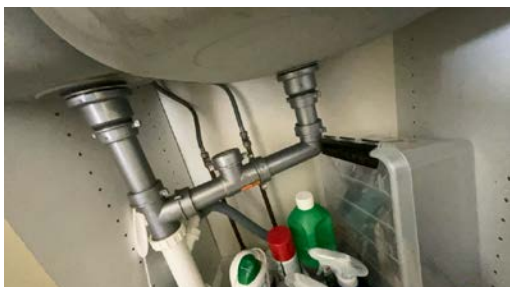
Del av rør til vann.
