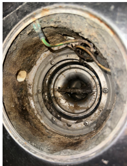
Stålsluk med klemring for membran
