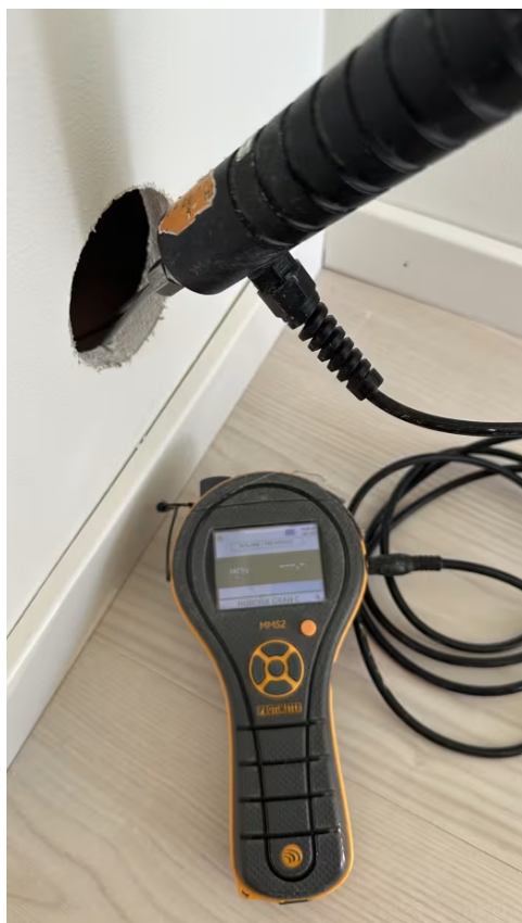
Ingen registrert fukt ved hulltaking.
