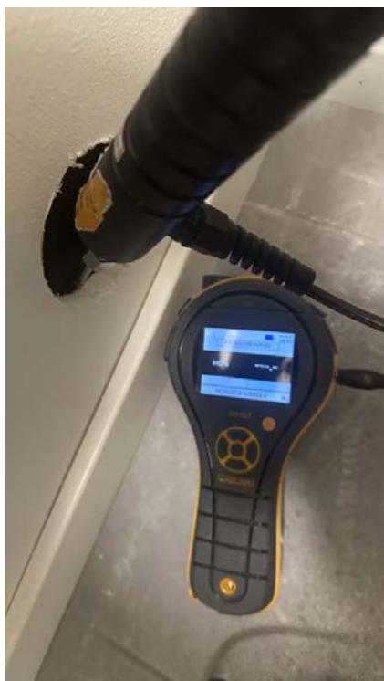
Ingen registrert fukt ved hulltaking.
