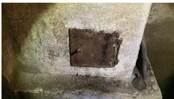
Sotluke i kjeller.
