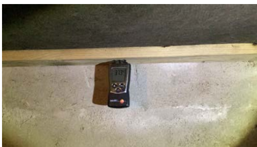
Fukttinnhold i treverk på over 30 vektprosent.
