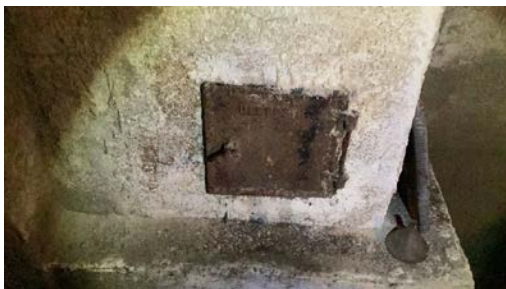
Sotluke i kjeller.
