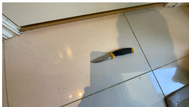
Det er registrert "bom"/manglende limdekning i/under flis på gulv ved inngangsdør og toalettrom i 1. etasje.
