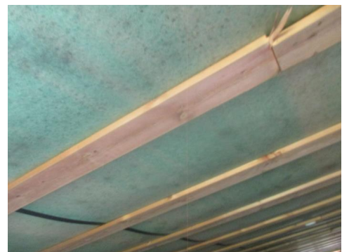
Deler av underliggende stubbloft.
