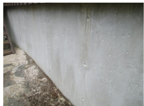
Deler av støpt mur på fjell.
