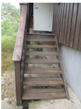
Trapp med repos ved overbygget inngangsparti.
