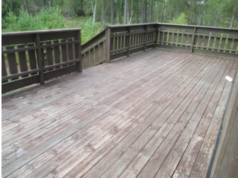
Deler av terrasse på endeveggen.
