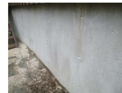
Deler av støpt mur på fjell.
