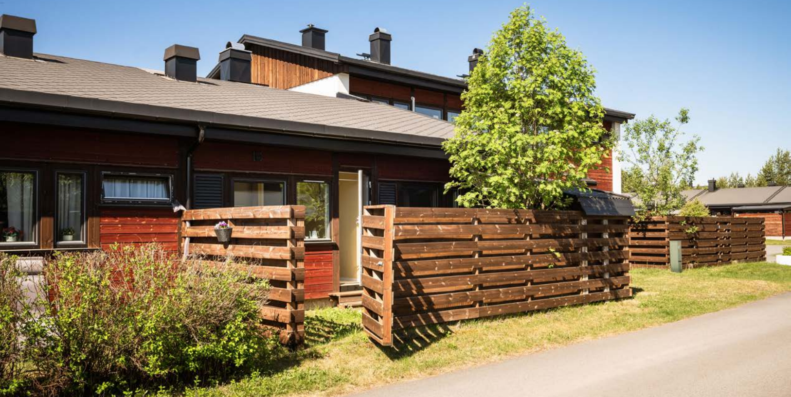
Hageflekk på østsiden av boligen, med inngjerding. Innenfor denne hageflekken er det et privat leskur, med praktisk plass til f.eks. sykkel, ved, hageredskaper eller lignende.
