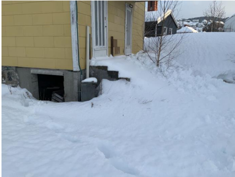
Støpt trapp til inngang.
