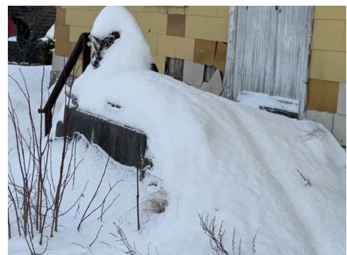
Støpt trapp på langvegg.
