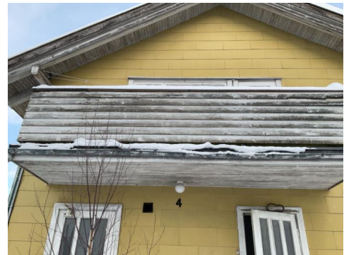
Utkraget veranda ute stolper.
