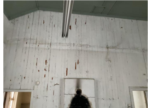
Panelvegg i forsamlingsrom.
