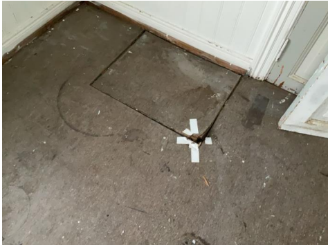
Luke i gulv til krypkjeller.
