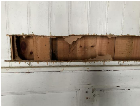
Yttervegger er isolert.
