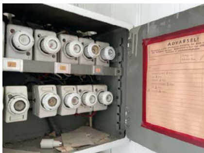
Sirkingssskap med skrusikringer.
