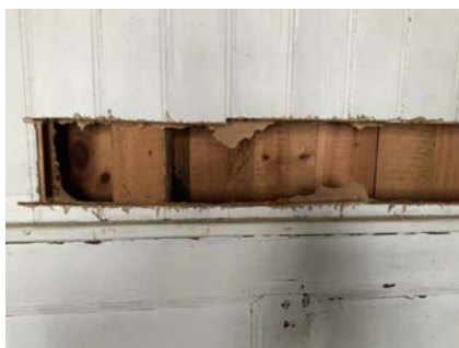
Yttervegger er uisolert.
