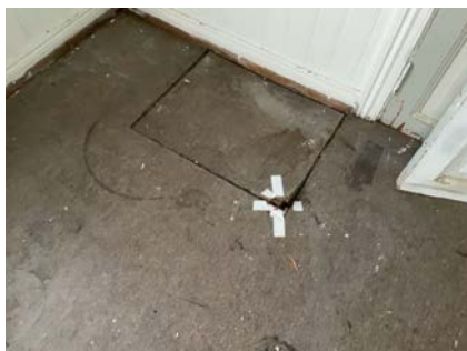
Luke i gulv til krypkjeller.
