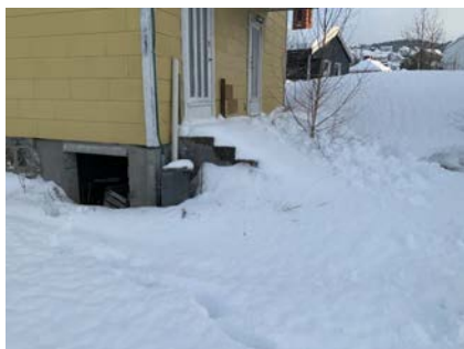
Støpt trapp til inngang.
